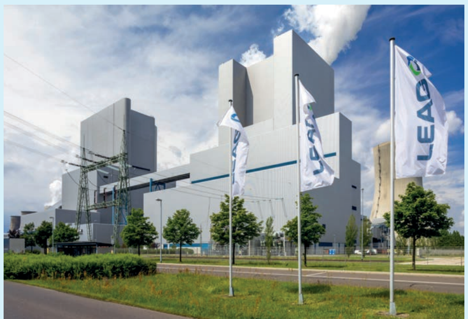
Das Kraftwerk Boxberg sorgt für eine sichere Energieversorgung trotz steigender fluktuierender Einspeisung aus erneuerbaren Energien Foto: LEAG
